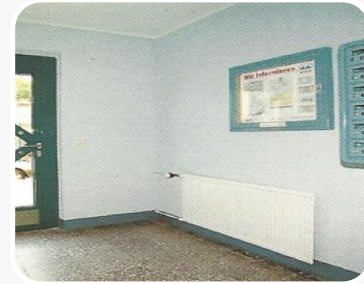
Новые входные двери
