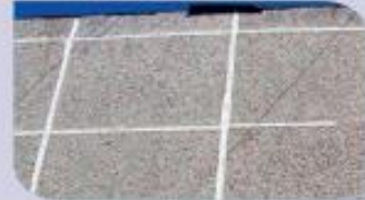
Ремонт и утепление межпанельных швов и облагораживание фасадов
