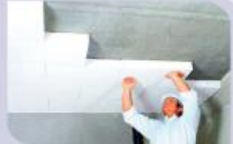
Утепление потолка подвала
