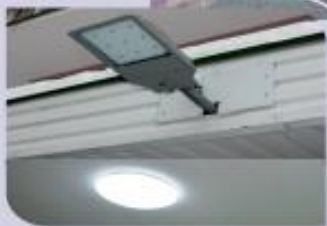
Установка подъездного и фасадного «умного» освещения
