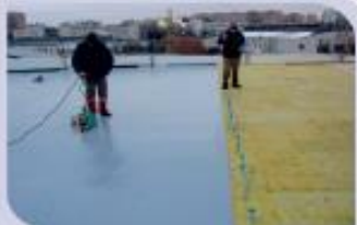
Утепление и ремонт кровли
