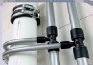
Замена трубопроводов водоснабжения и канализации в подвалах
