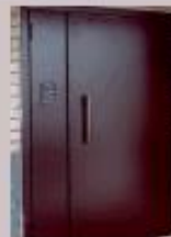
Замена входных дверей на утепленные
