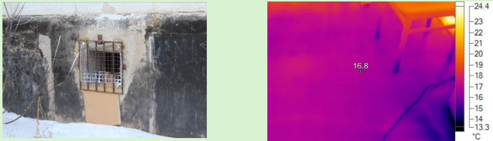
Отсутствие теплоизоляции распределительных трубопроводов системы отопления и ГВС в неотапливаемом подвале
