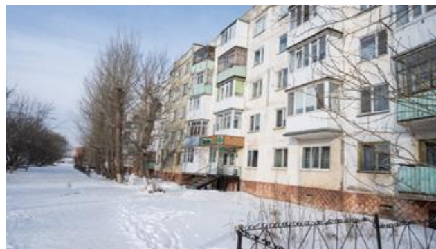
Многоквартирный жилой дом в г. Кокшетау (пилотный проект)
